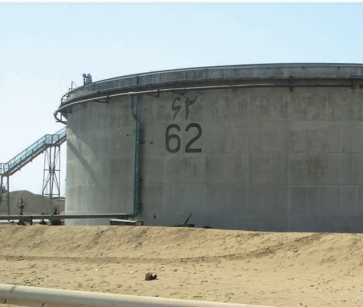
احداث دیوار خاکی در اطراف مخازن نفت
