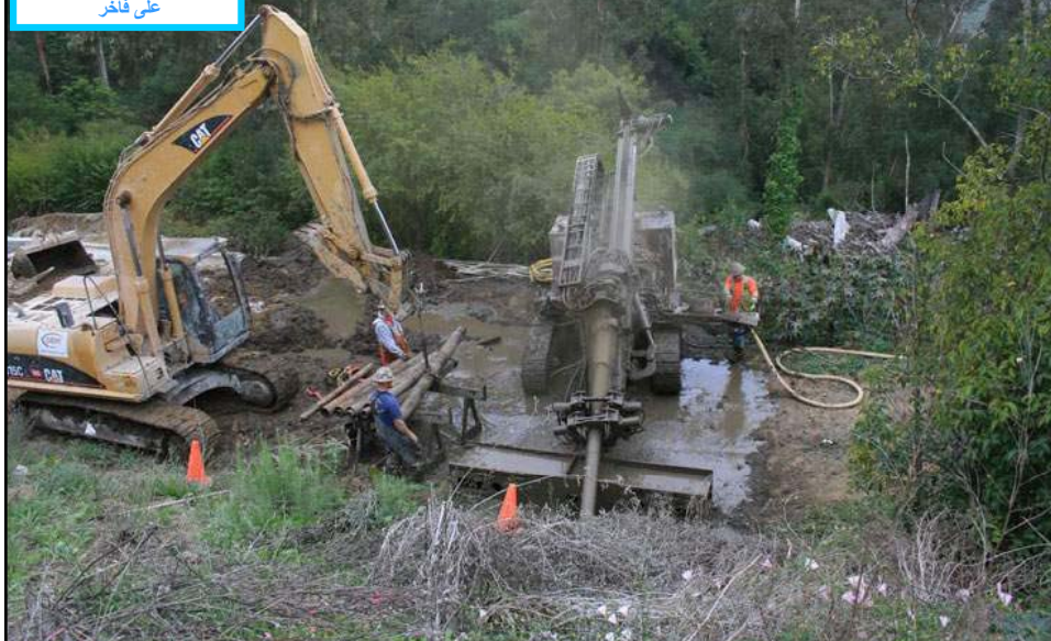
اجرای زهکش افقی با ماشین حفاری گمانه
