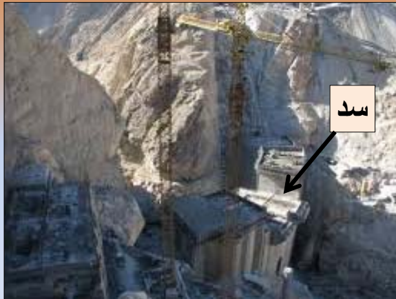
سد کارون 4 در هنگام ساخت
