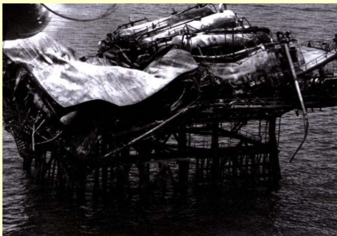
اجرای سازه های دریایی علی فاخر
