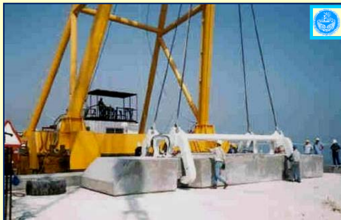
اجرای اسکله HDDI در بحرین با بلوکهای ۱۶۰ تنی
