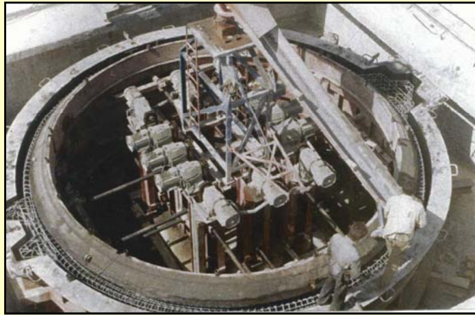
شبكة های آرماتور بافته شده در داخل قالب کیسون قرار گرفته و با قیف مخصوص بتن ریزی می گردد
