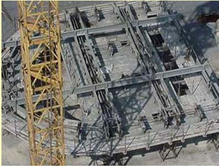
قالب لغزنده از نمای نزدیک
