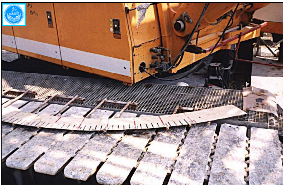
شابلون نصب شده بر روی جرثقیل زیر اتاق برای تنظیم زاویه افقی بازو
