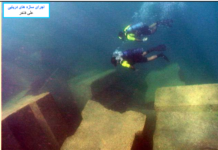
کنترل چیدمان آرمور به کمک غواص در بندر پتروشیمی عسلویه در عمق آب ۳۵ متر
