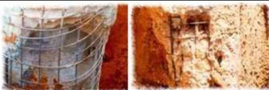
نمونه هایی از آسیب دیدگی شمع حین اجرا
